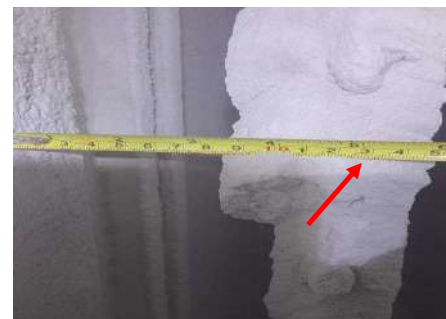
Fig. 10 DE-CE misalignment.
